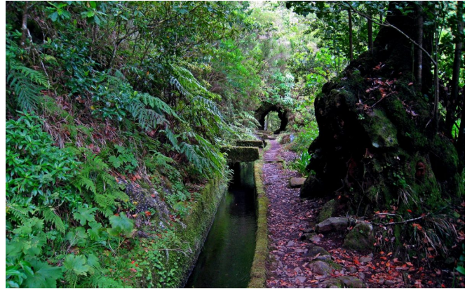
Tunnelwanderung auf der Levada do Norte
