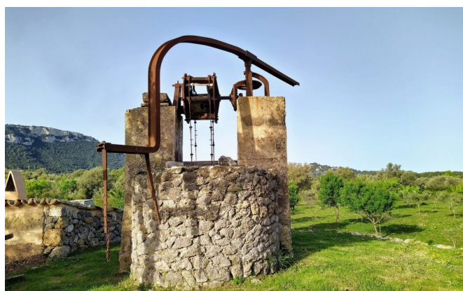
Von Eseln oder Maultieren wurden bis ca. Mitte des 20. Jahrhundert die Brunnen angetrieben.
