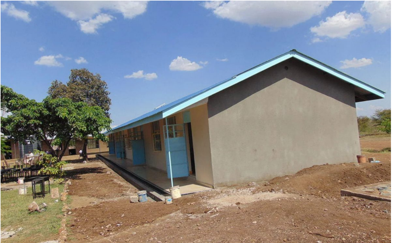
Komplette Renovierung Schulgebäude mit 4 Klassenräumen an der Sekundarschule Kikwe (Foto: Eckard Krause)
