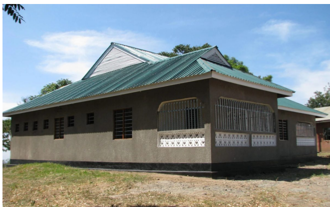
Was haben wir alles schon erreicht: Übergabe Schulungszentrum Nambala nach 5 Jahren Bauzeit (Foto: Eckard Krause)
